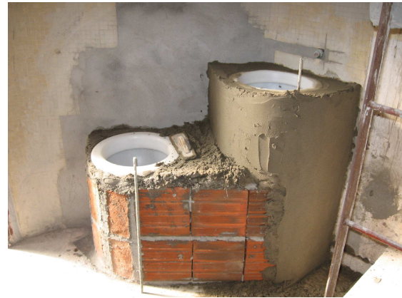
Cajón lleno y comienzo del revoque
