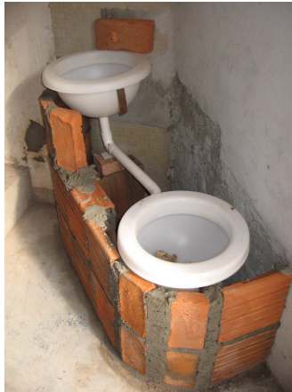
Armado de cajón de ticholo
